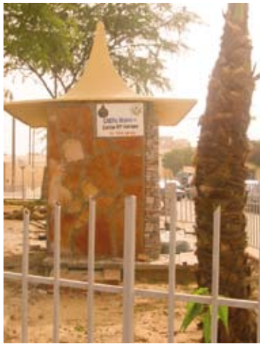
La latrine VIP s'intégrant parfaitement avec l'environnement
