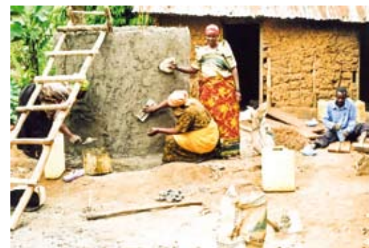
Les femmes ougandaises prennent le devant pour la construction d'un impluvium
