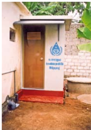
Toilette en milieu scolaire. © Decade Service
